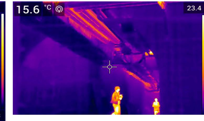
Condotti di ventilazione in uso posizionati al di sotto di condotti apparentemente non attivi
